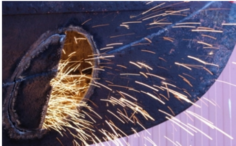
De inbouw van de boegschroef
