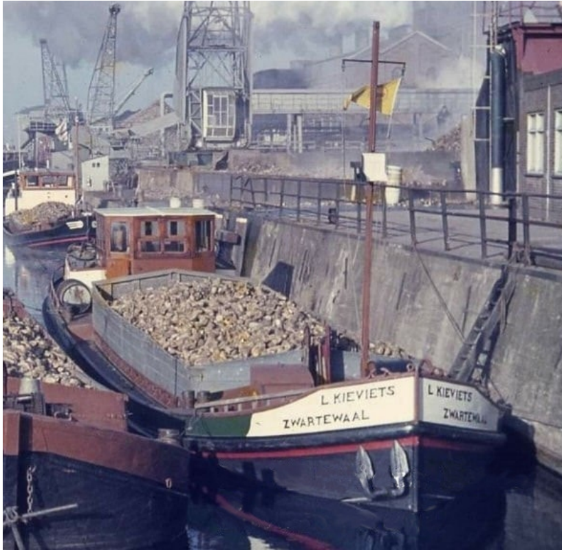
Lossen bij de Suikerfabriek V.C.S. Zevenhuizen.
