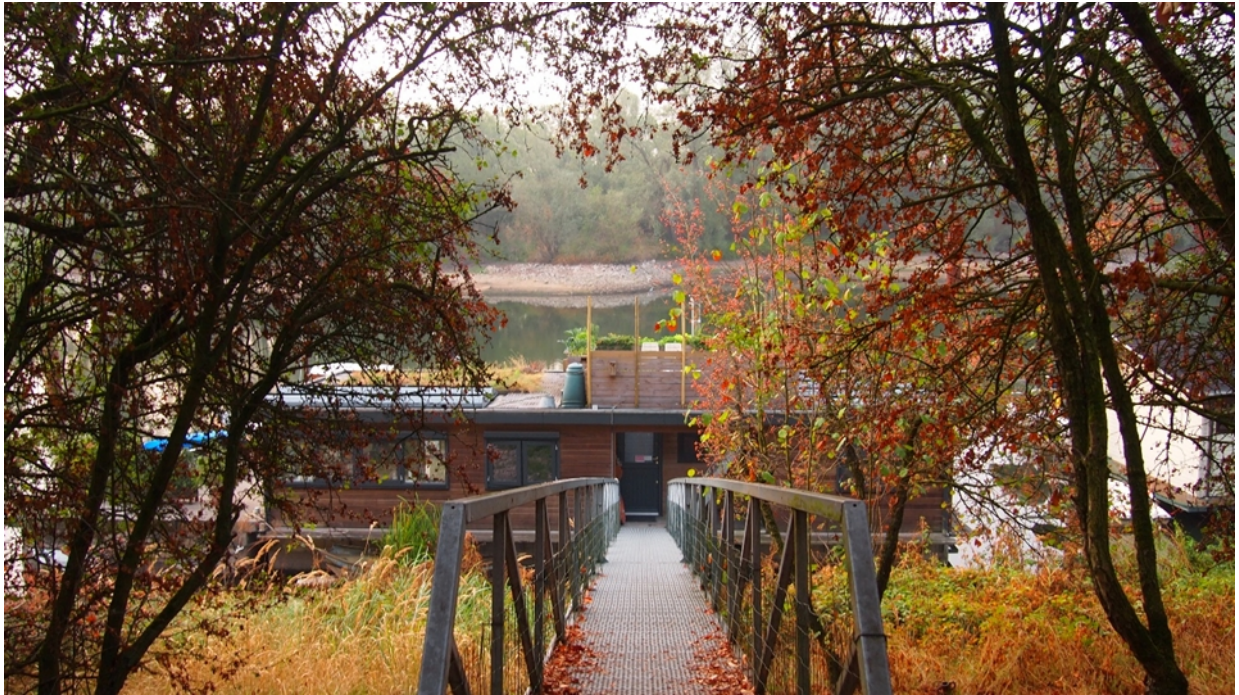
De watervilla in de Steeg aan de Steegse Haven, met daktuin en zonnepanelen.
