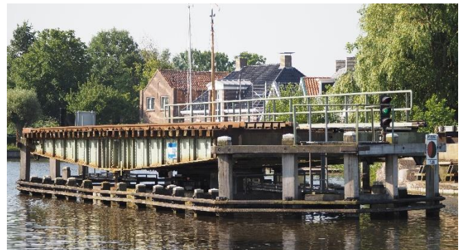
De spoorbrug over De Wimerts
