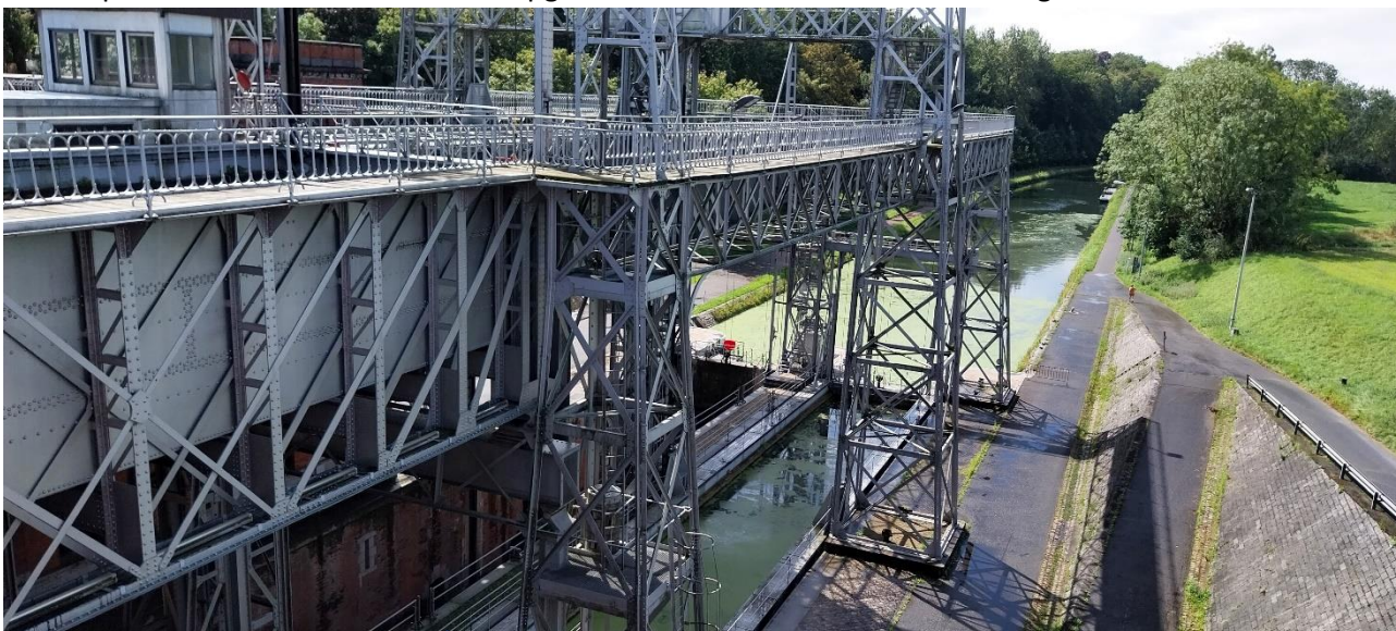
Aan de portalen worden de hefdeuren opgehesen. De rechter liftbak is nu neer gelaten.
