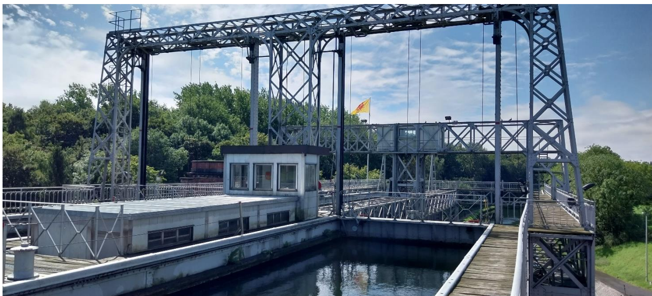
Aan de portalen worden de hefdeuren opgehesen. De rechter liftbak is nu neer gelaten.
