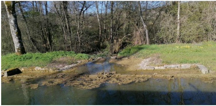
Een voorbeeld van een overloop naar de Marne
